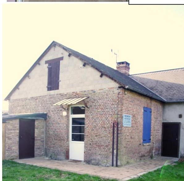
Création d'un trottoir permettant aux personnes à mobilités réduites de se rendre à la bibliothèque
